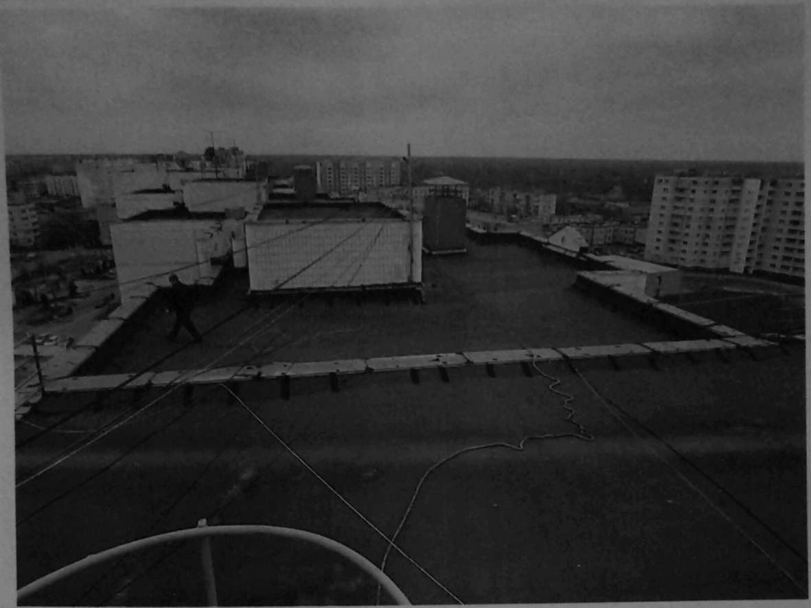
Фото 5. Общий вид кровли
