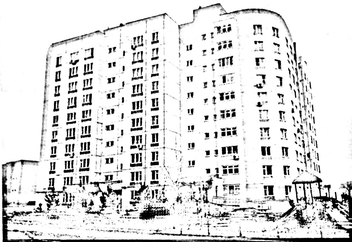
Фото 1.Общий вид здания. 5-я и 6-я секции
