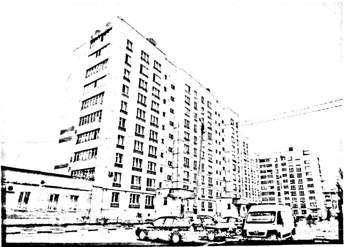
Фото 3. Общий вид здания. 1...5-я секции
