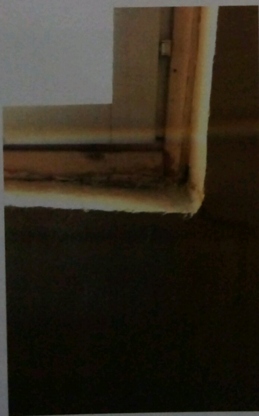
Фото16, 17. Следы замкания и поражения гнилью оконных рам. Следы протечек на стенах.
